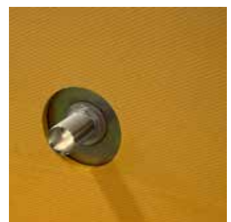
Ablaufventil von unten
