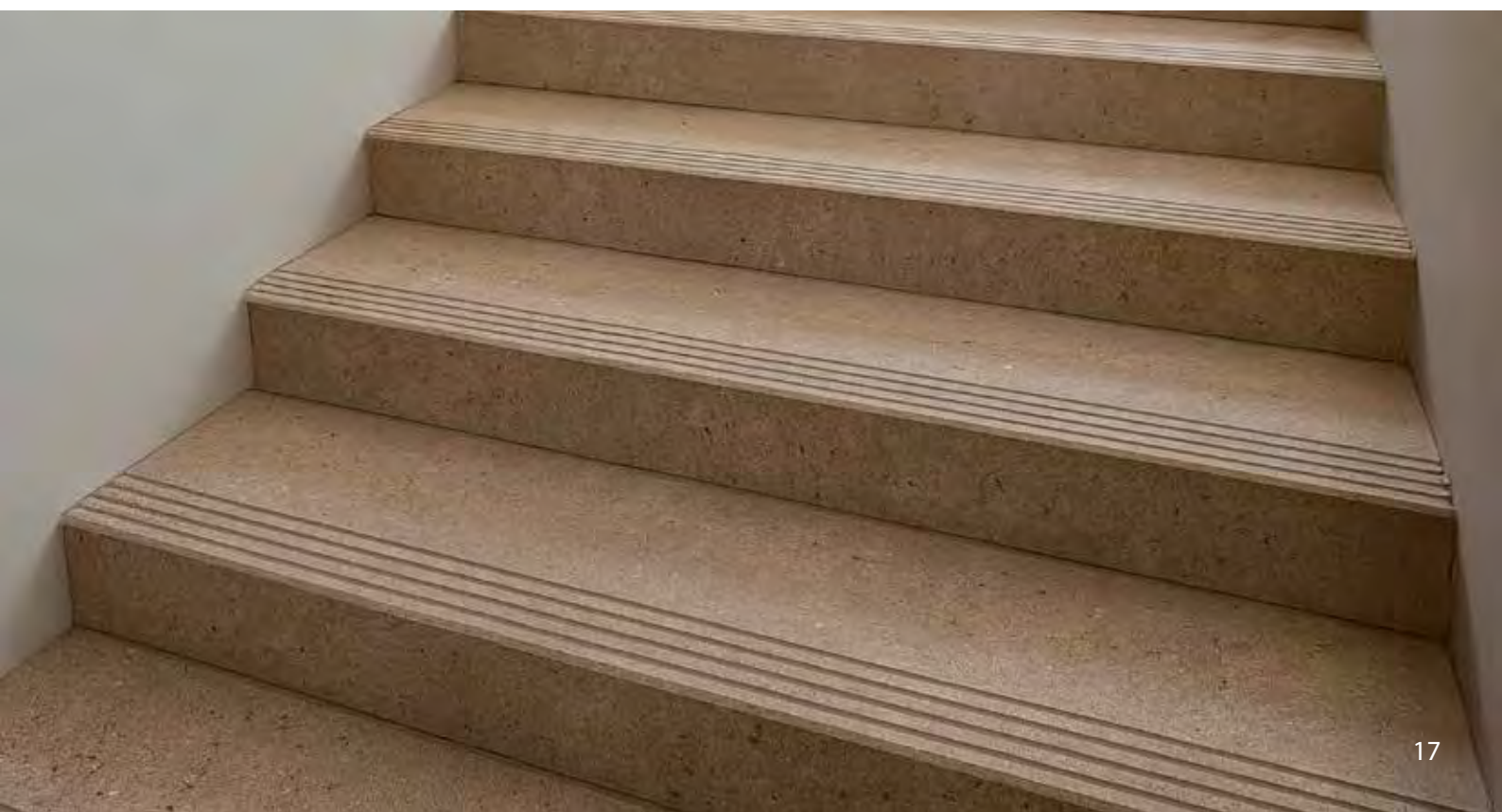
Stufe mit angeklebten Schenkel
